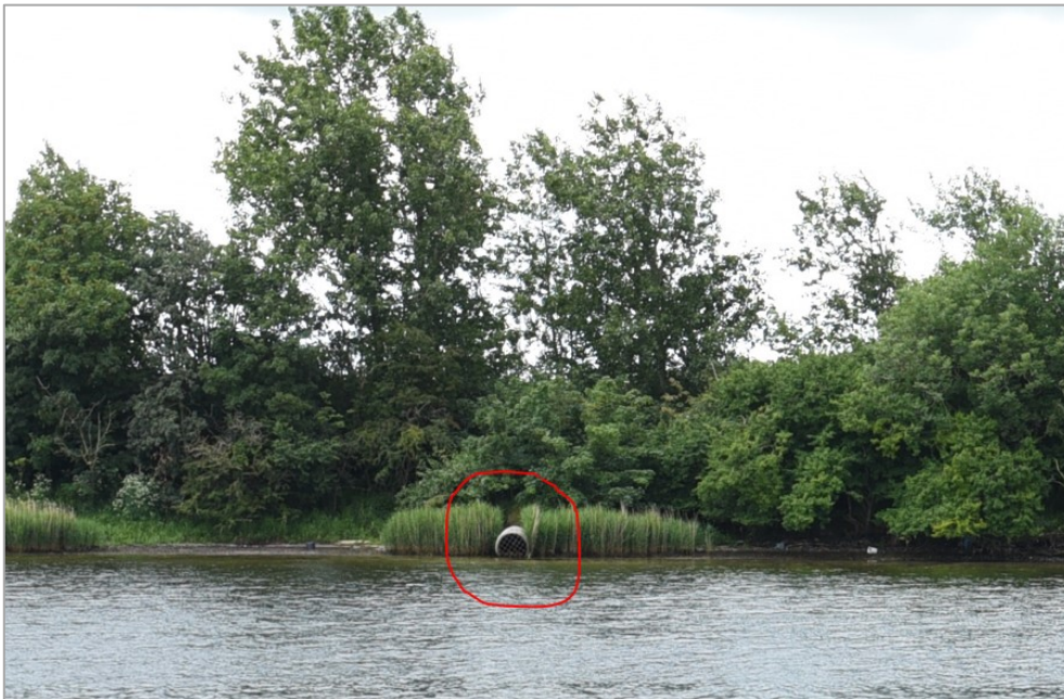
Figur 3-16: Foto af betonudløb fra oplagsområdet – taget fra nord mod syd på tværs af fjorden.
