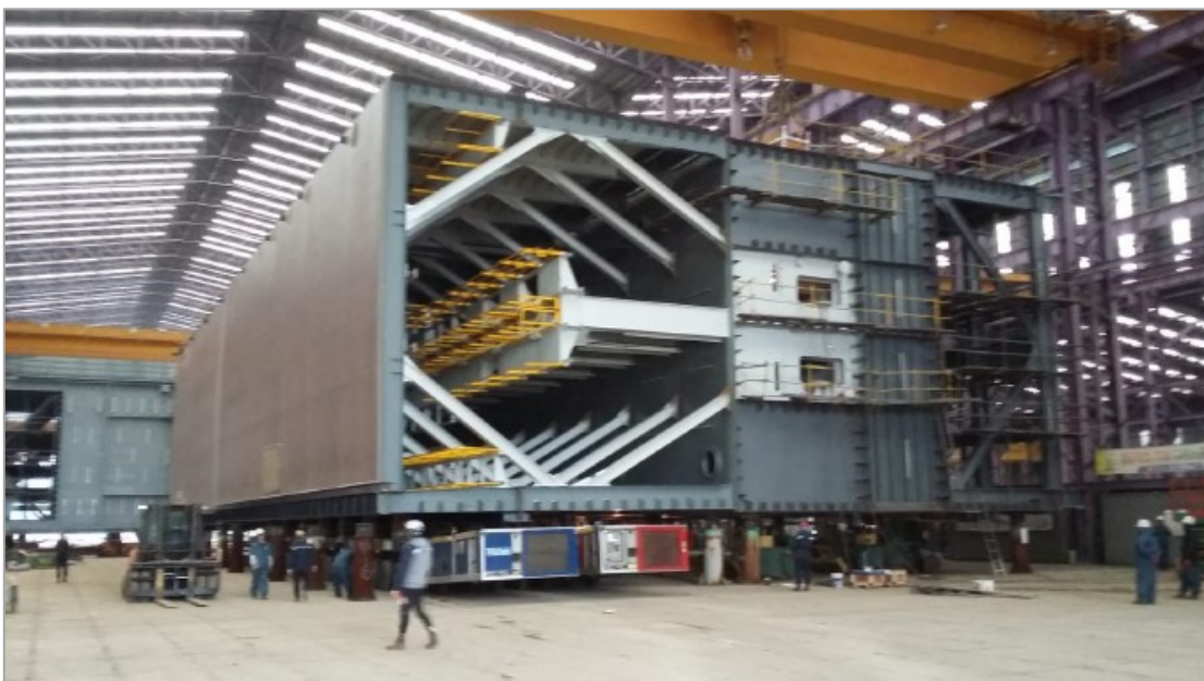
Figur 7-1: Port under udførelse, ref. /B10/. Bemærk at porten ligger ned på siden med toppen mod venstre i billedet.
