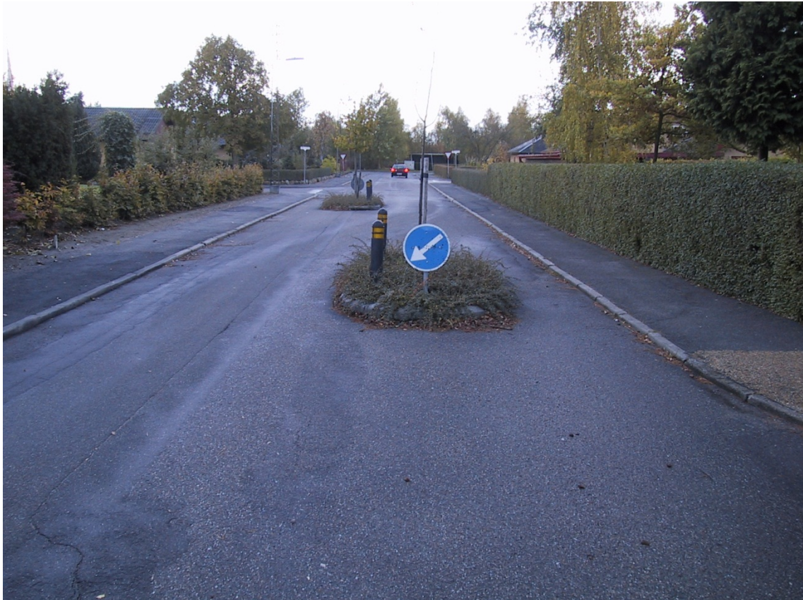
Foto: taget af park og vej, Hastighedsdæmpende foranstaltninger på Brogårdsvej Søllested, 2017
