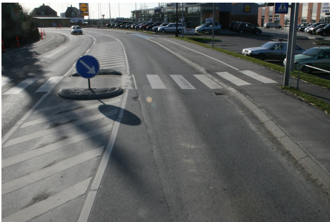
Foto: taget af Park og vej, Helleanlæg med fodgængerovergang venstresvingsbane og blå cykelfelter, 2017
