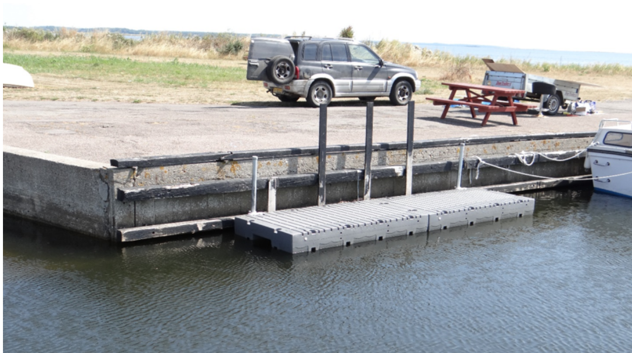
Figur 9. Støbt plastflydebro i Errindlev havn, opsat i forbindelse med Naturlandet. Broen skiller sig her ikke markant ud fra det eksisterende miljø.
