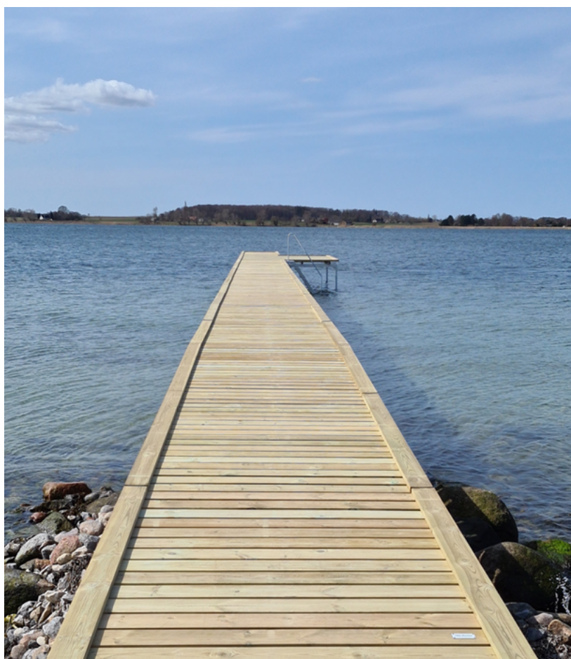
Figur 3. Fast træ/stålbrop med trædæk og mindre sideplatform.
