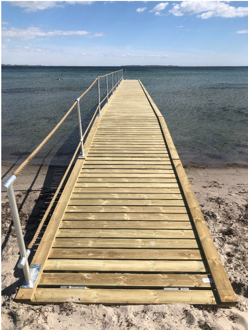
Figur 1. Fast træ/stålbros med simpelt rækværk.
