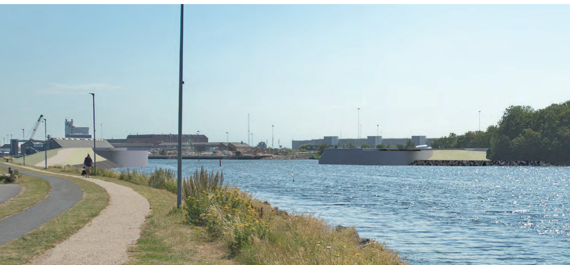
Skydeporten er i portkammeret ved normale vandstande, så der er fri passage for gennemsejling (illustration af Hasløv og Kjærsgaard)
