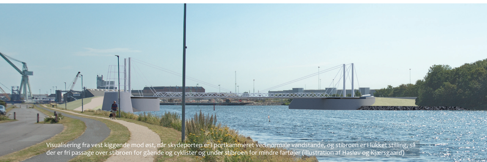
Visualisering fra vest kiggende mod øst, når skydeporten og stibroen er i lukket stilling ved højvande (illustration af Hasløv og Kjærsgaard)
