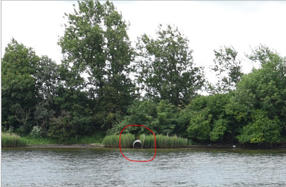
Figur 3-16: Foto af betonudløb fra oplagsområdet – taget fra nord mod syd på tværs af fjorden.
