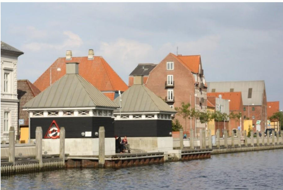
Havnegade med højvandsmuren, 2009
