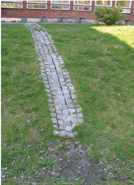
Figur 9: Afledning af regnvand til græsplæne i Augustenborg, Malmø. Foto Orbicon
