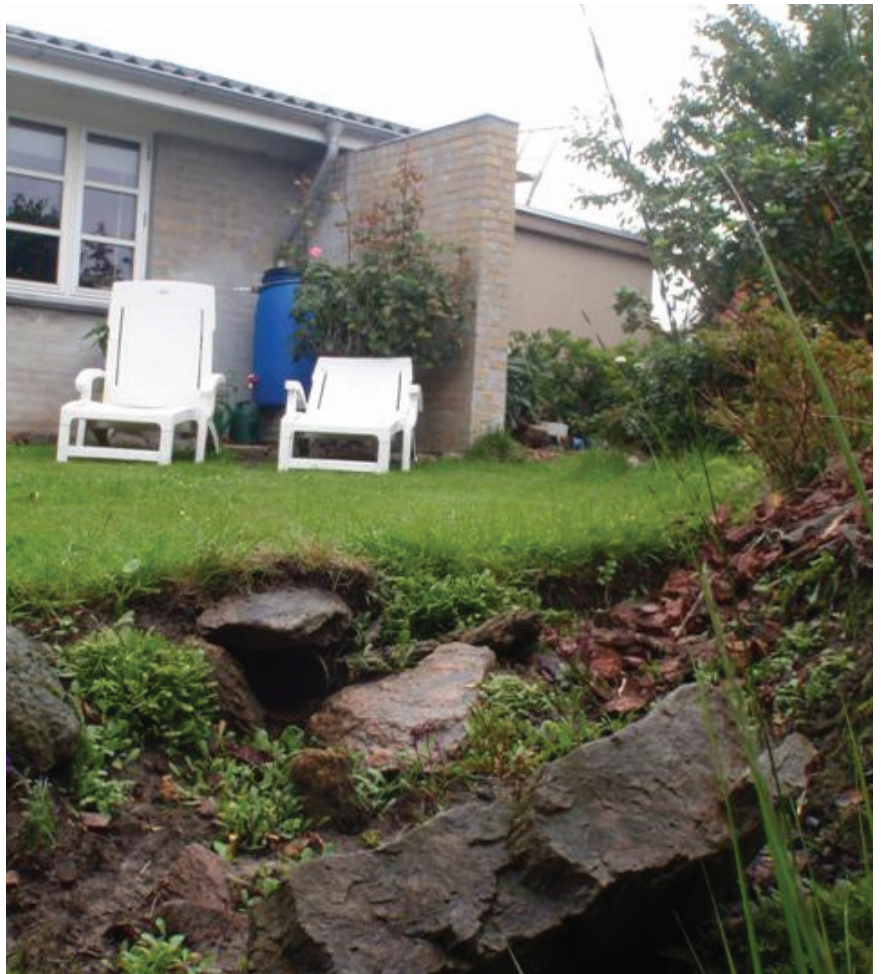
Figur 20: Tagvandet ledes via et rør til regnbedet (i forgrunden skjult under en sten). På nedløbsrøret er desuden opsat en tønde til opsamling af regnvand. Slagslunde, Egedal Kommune. Foto Orbicon.
