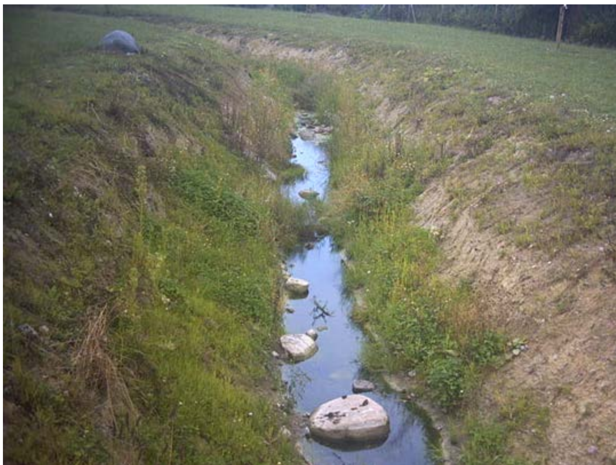
Tidligere rørlagt vandløb, genåbnet og restaureret med sten og groft bundmateriale
